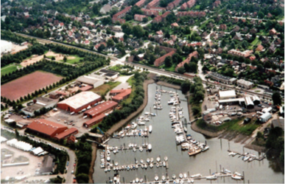
Die Heuerwerft am Rüschanal in Finkenwerder.
