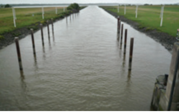
Die Mündung der Pinnau vom Sperrwerk aus.
