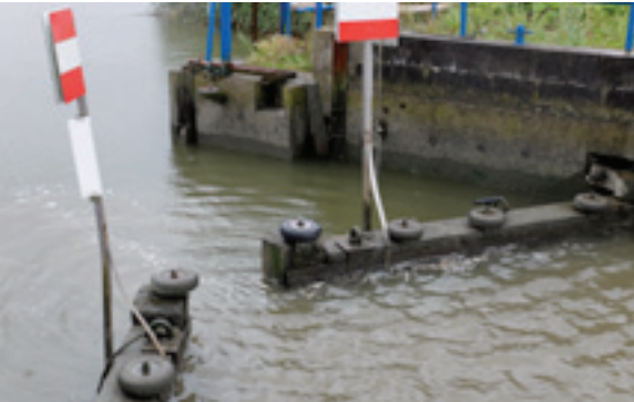
Bei Ausgleich öffnet sich das Tor von selbst. Man beachte die Schutzrollen!
