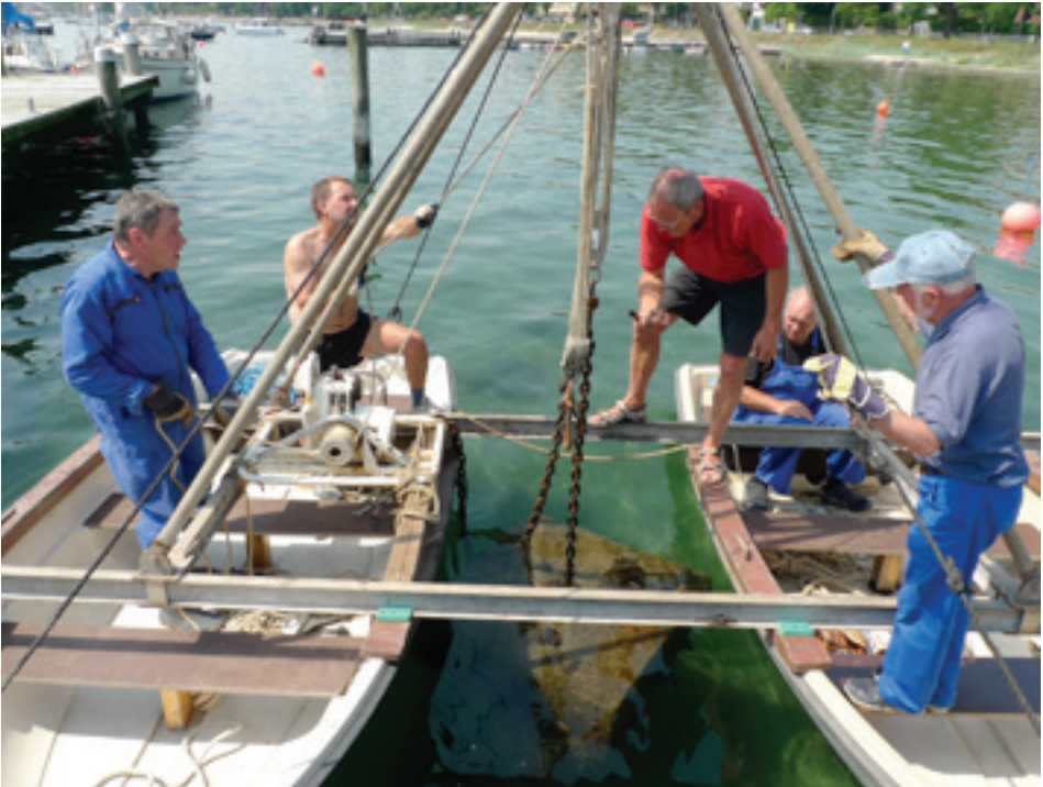
Umsetzen der Mooringsteine mit Hilfe des Kran-Katamarans. (Foto: Cathrin Schaper)
