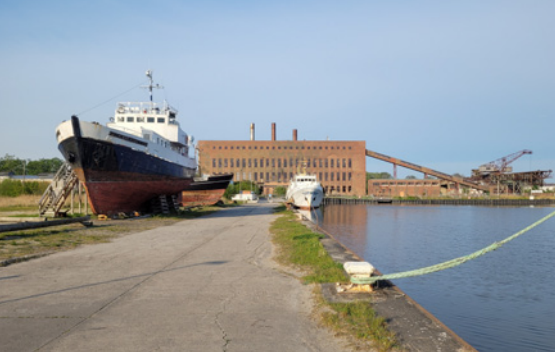
Die Ruine des alten Raketenforschungswerks in Peenemünde
