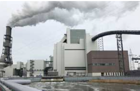
Das Kraftwerk mit Kühlturm und Kühlwasserauslauf (Foto: Peter Kaphammel)
