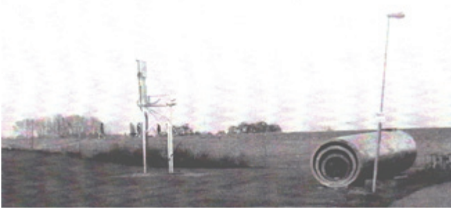
Nun ist sie weg, die Windenergieanlage im Hamburger Yachthafen. (Foto: Karl-Heinz Baumgartner)
