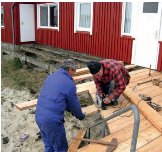
Freiwillige Helfer bei der Reparatur der Terrasse
